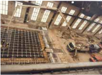
Umbau der Halle 1986-2003 Betonieren des Spannfelds
