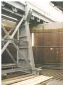
ehemalige Grube des Turbinenprüfstands
