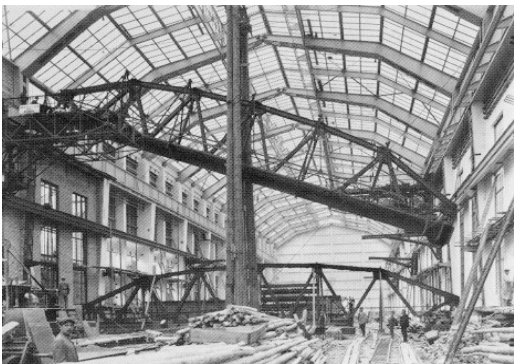
Einbringen eines Laufkrans am 15.05.1912; [1]
